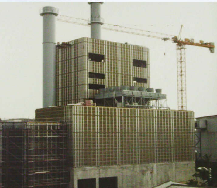
Das Heizkraftwerk Schwerin-Lankow im Bau
