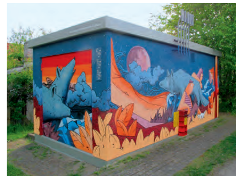
Gasdruckregelanlage Wolfsschlucht in Schwerin-Friedrichsthal
