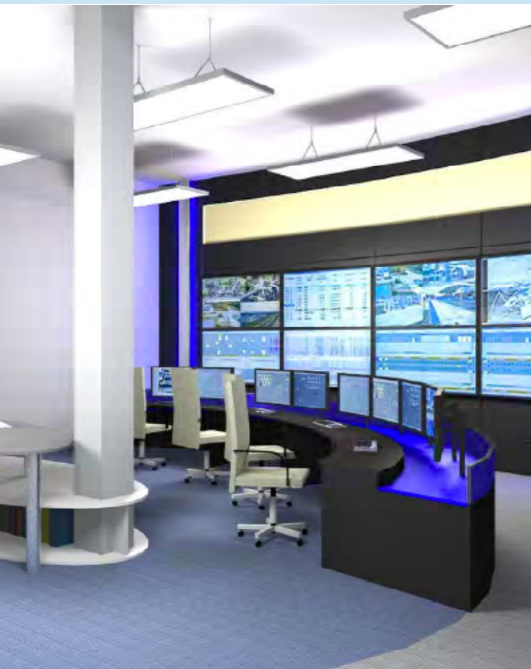
Die Erneuerung der Kraftwerksleitwarte am Standort Schwerin Süd bildet die Grundlage für zahlreiche Prozessoptimierungen für alle Erzeugungsanlagen.
