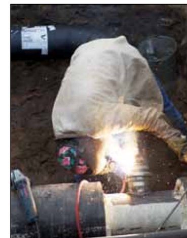
Schweißarbeiten an den neuen Fernwärmeleitungen
