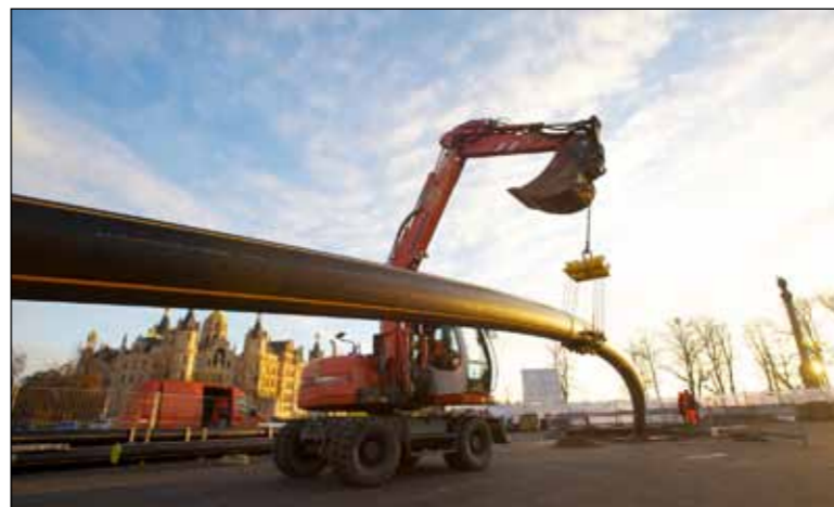
Um das Schweriner Schloss mit Fernwärme zu versorgen, wurden die Leitungen mit Hilfe einer speziellen Bohrtechnik direkt unter dem Burgsee verlegt Fotos: SWS
