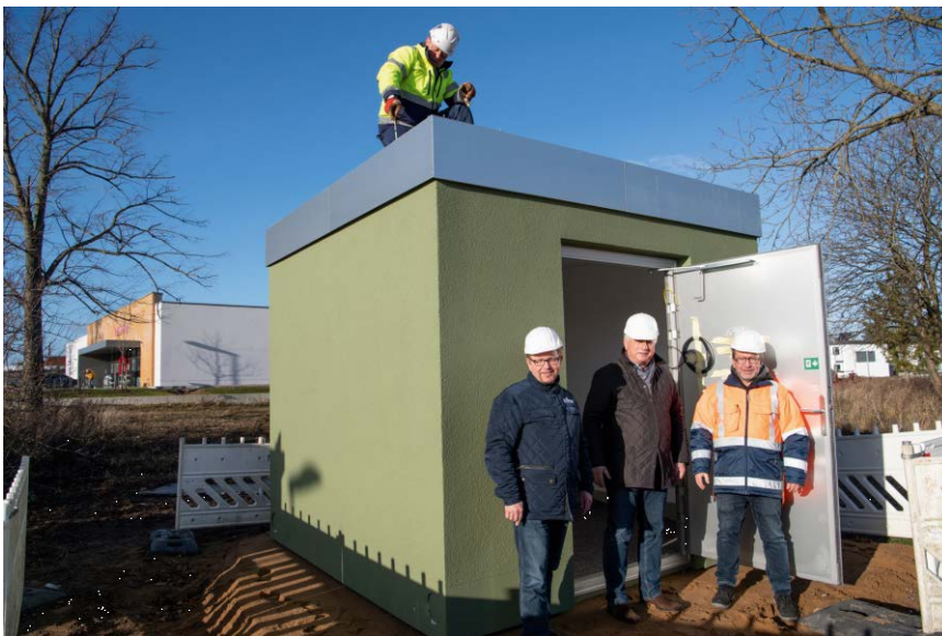
Mario Montag (v.l.) von den Stadtwerken Schwerin, Geschäftsführer Dr. Josef Wolf und Michael Manthe von der ausführenden Firma C&S Breitband GmbH bei der Errichtung des POP-Standorts in der Güstrower Straße Foto: maxpress
