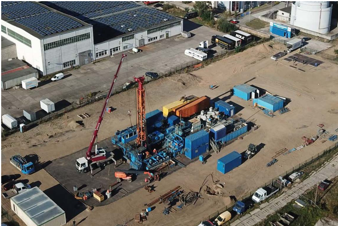
BU: Aufrichtung des Bohrturms im September 2018.
