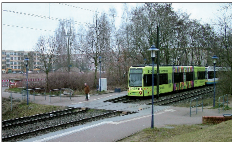
Die BUGA-Bahn des Schweriner Nahverkehrs an der Haltestelle Leibnizstraße. Im Hintergrund wird am neuen BUGA-Parkplatz gebaut Fotos: NVS
