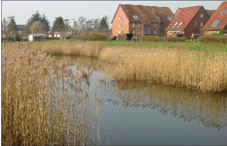
Der naturnah gestaltete Regenwasseranlagen an der Brüsewitzer Straße in Friedrichsthal wurde harmonisch in die Wohnanlage eingepasst Fotos: SAE/max
