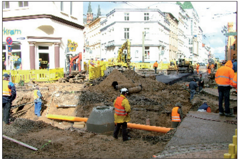
Rund um die Uhr arbeiteten alle beteiligten Bauträger Hand in Hand, um die Straße wieder für den Verkehr frei zu machen Fotos: NVS
