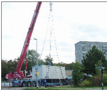
Das neue Unterwerk beim Aufbau durch den 180-Tonnen-Kran Foto: NVS
