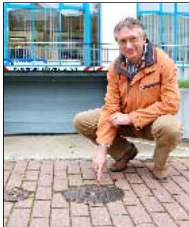
Volkhardt Zillmann zeigt auf die Kappe eines Hydranten. Links daneben befindet sich die Kappe eines Schiebers
