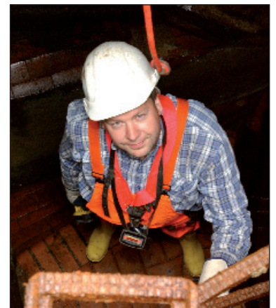
Die Kanalinspektion zählt zu den Leistungen der WAG Foto: maxress/max
