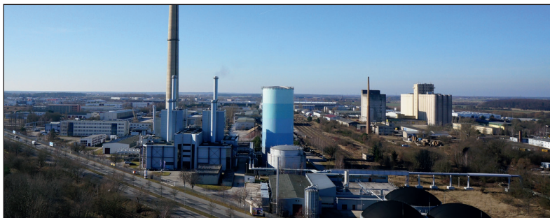
Dank Kraft-Wärme-Kopplung werden jährlich große Mengen CO 2 eingespart Foto: SWS
